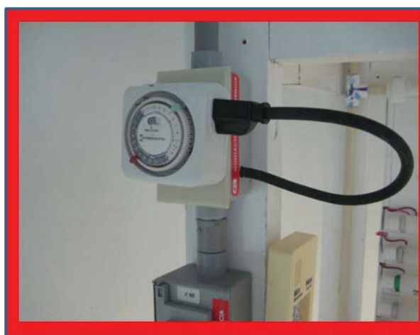
Fig. 17 Detalle fotográfico del controlador de tiempo en el sistema sistema “B” de producción de microalgas con luz monocromática
