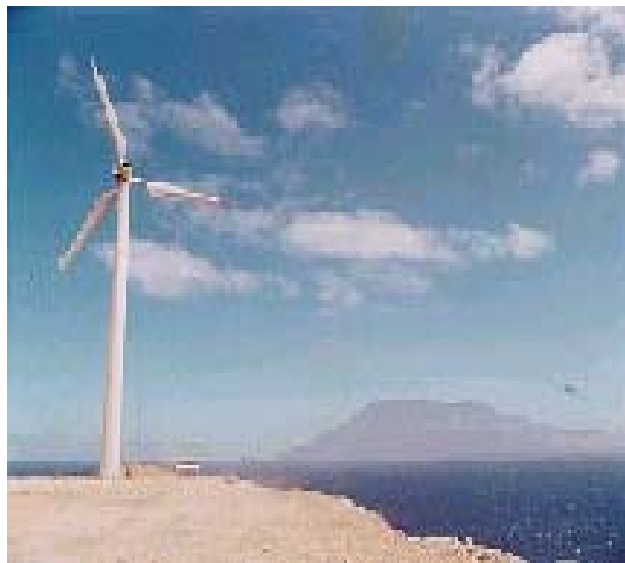
Figura 6.7.1 Proyecto eólico establecido en Baja California Sur (GTZ, 2004).
