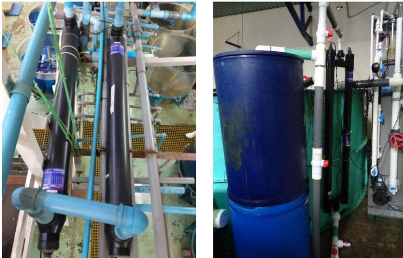
Figura 1.2.19. Reactores con lámparas de ultravioleta (color negro) con operación horizontal en Laboratorio Central de Cultivos Marinos, Universidad Católica del Norte, Chile (izq.) y con operación vertical en Parque Marino, Costa Rica (der.). (autor G. Merino y J. Chacón-Guzmán).
