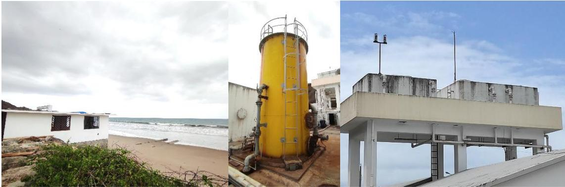
**Figura 1.6.12.** Primer sistema de captación de agua, **A.** Líneas de captación, **B.** filtro de grava y **C.** Reservorios de 50 y 100 m<sup>3</sup>, CENAIM-ESPOL. (autora S. Reinoso)
