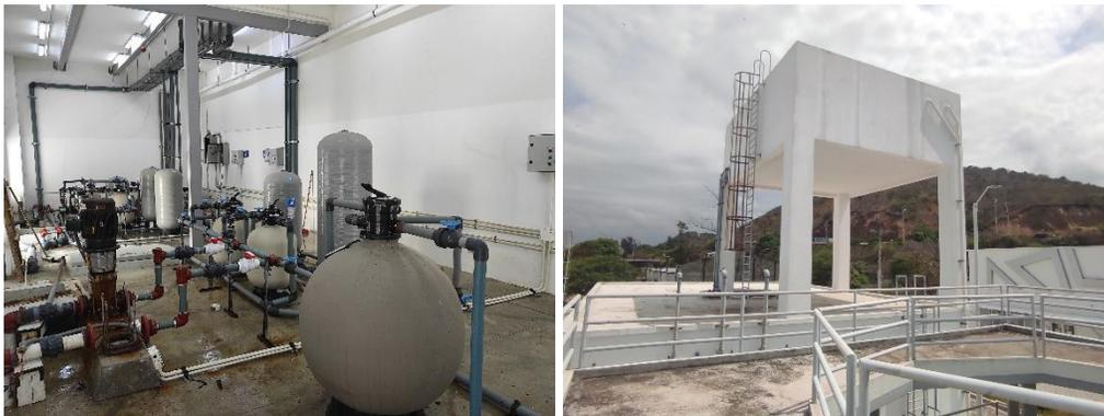
**Figura 1.6.13.** Segundo sistema de captación de agua, **A.** filtros de arena y **B.** Reservorio de 50 m<sup>3</sup>, CENAIM-ESPOL. (autora S. Reinoso)
