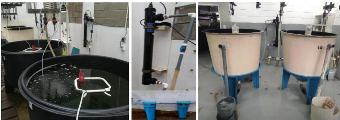
**Figura 1.6.5.** **A.** Tanques de 1 m<sup>3</sup> con flujo abierto, **B.** Filtro UV, y **C.** filtros de cartucho de 1 y 5  $\mu\text{m}$ , **D.** tanques de incubación de huevos de huayaibe, robalo y cobia, CENAIM-ESPOL. (autora S. Reinoso)
