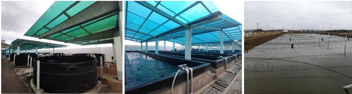
**Figura 1.6.7.** *A. Tanques de 6 y 12 m<sup>3</sup> circulares, B. raceways de 50 m<sup>3</sup> ubicados en exterior bajo cubierta translúcida, C. Estanques de tierra para experimentación con el cultivo de peces marinos, ubicados en la Estación Experimental “Palmar”, CENAIM-ESPOL. (autora S. Reinoso)*
