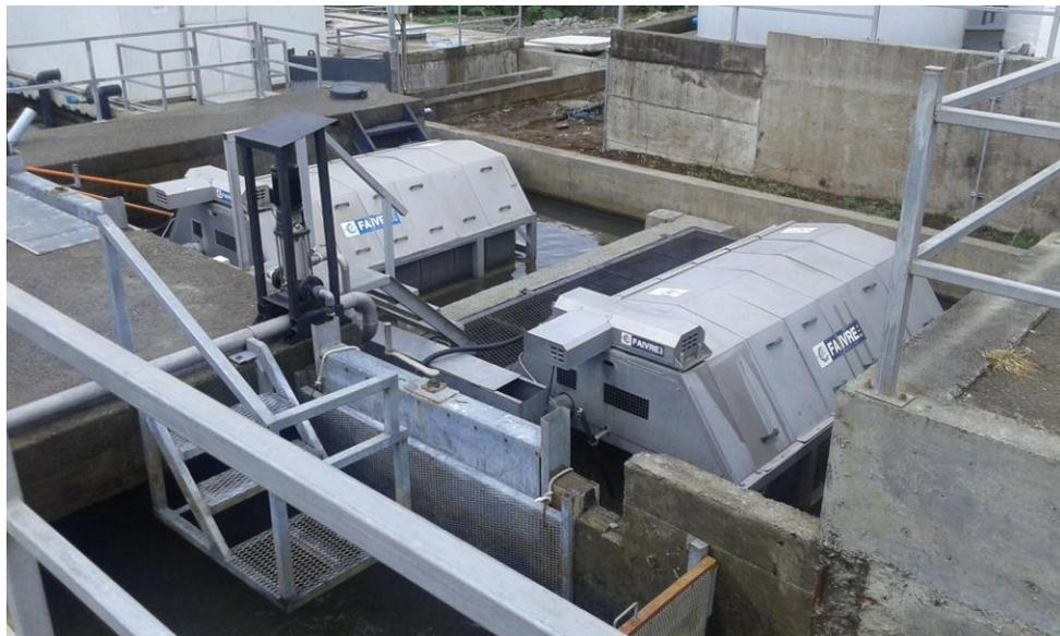
Figura 1.2.17. Rotofiltros para la remoción de sólidos suspendidos. (autor J. Barraza)
