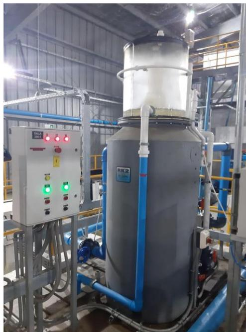
Figura 1.2.18. Fraccionadores de espuma utilizados para la remoción de sólidos suspendidos y disueltos en sistemas de acuicultura con recirculación de agua. (autor G. Merino)
