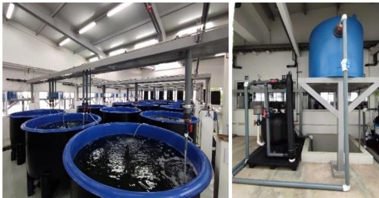
**Figura 1.6.6.** Tanques de 2 m<sup>3</sup> acoplados a un sistema de recirculación, CENAIM-ESPOL. (autora S. Reinoso).
