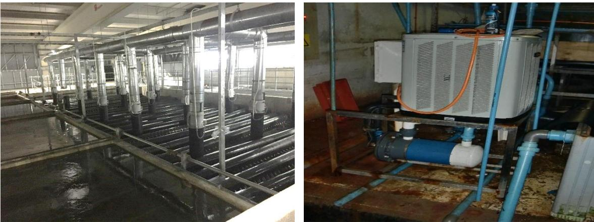
Figura 1.2.24. Torres de desgasificación (izq) y bomba de calor (der). Las torres de desgasificación se utilizan para remover gases y/o para equilibrar las saturaciones. La bomba de calor es muy utilizada para enfriar y/o calentar el agua y que podría conllevar a la condición de GBD (gas bubble disease). (autor G. Merino)
