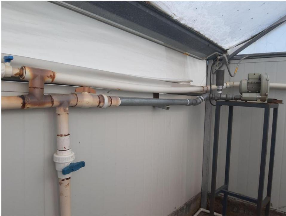
Figura 1.2.23. Soplador con tubería efluente metálica para disipar calor. Aun así, la tubería de PVC (izq.) muestra los efectos del deterioro por calentamiento del aire. Centro de Acuicultura, México. (autor G. Merino)
