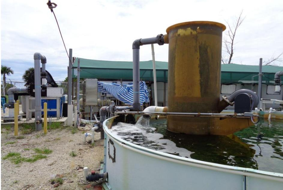
Figura 1.2.25. Unidad de desorción de sulfuro de hidrógeno del agua de mar antes de ser ingresada al Centro de Cultivos Marinos de la Universidad de Miami, Florida, USA. (autor G. Merino)
