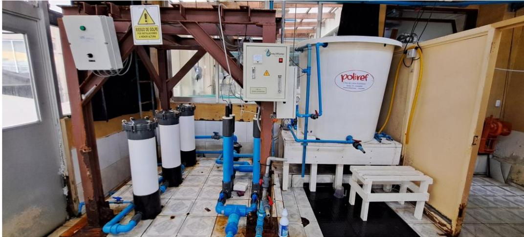
Figura 1.2.20. Sistema de inyección de ozono por descarga eléctrica para desinfección de agua marina que será utilizada para cultivo de microalgas. Laboratorio Central de Cultivos Marinos, Facultad de Ciencias del Mar, Coquimbo, Chile. (autor G. Merino).
