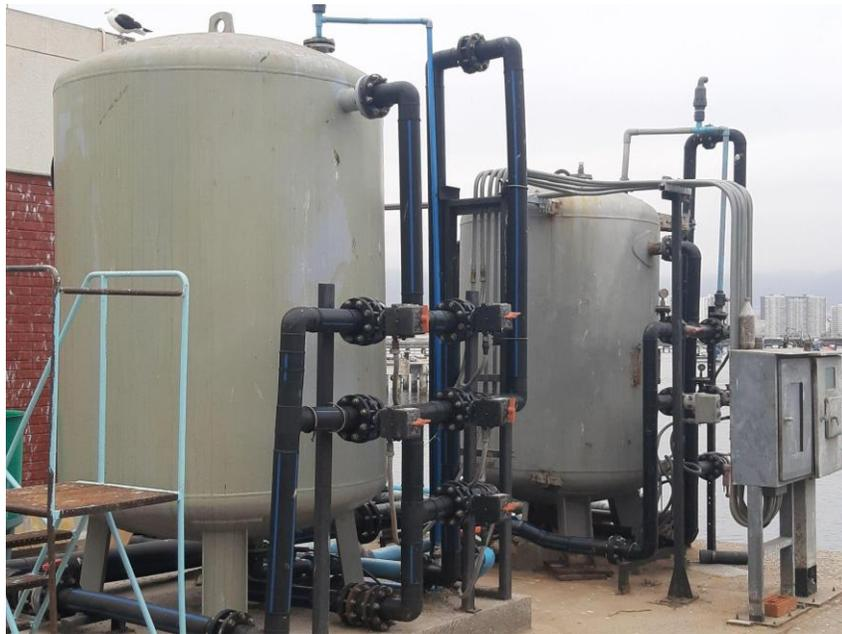
Figura 1.2.16. Filtros presurizados de arena para filtrar a 50  $\mu\text{m}$  un caudal de 50  $\text{m}^3/\text{h}$  cada uno, instalados en Laboratorio Central de Cultivos Marinos, Facultad de Ciencias del Mar, Universidad Católica del Norte, Coquimbo, Chile. (autor G. Merino)
