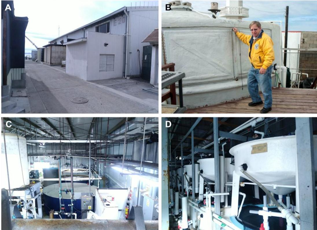
**Figura 1.7.1.** Instalaciones del LBA-FCM donde se lleva a cabo actividades de investigación y docencia en el área de acuicultura. A) imagen general de la unidad, B) tanque de reproductores para peces marinos, C) área de crianza con tanques de 8 m<sup>3</sup>, D) sistema de 12 tanques de 500 L con sistema cerrado para estudios de investigación en peces marinos. (Autor. UBP-FCM-UABC).
