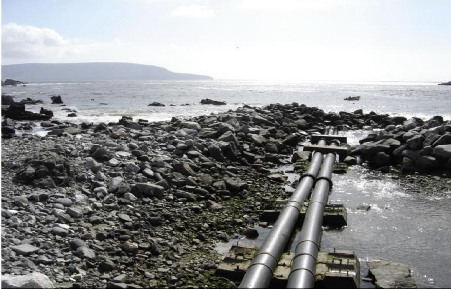
Figura 1.2.6. Líneas paralelas de succión de agua marina instaladas en la zona de Caldera, Chile. Notar el sistema de anclaje para la zona de oleaje. (autor G. Merino)
