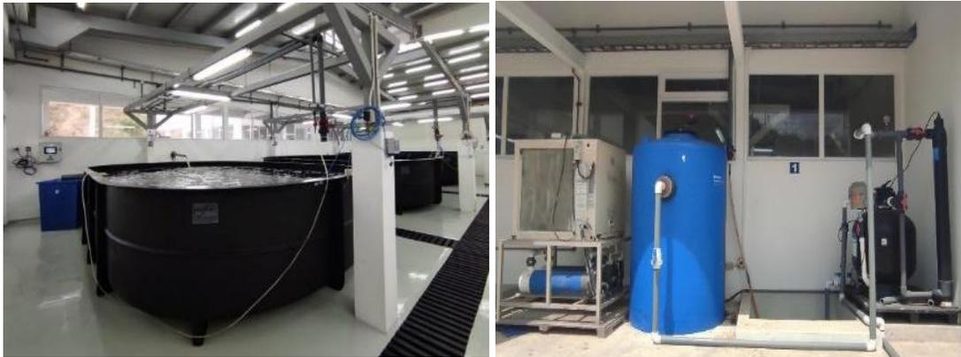
**Figura 1.6.4.** Laboratorio de levantamiento de reproductores, **A.** tanques de cultivo de 20 m<sup>3</sup> y **B.** sistema de recirculación, CENAIM-ESPOL. (autora S. Reinoso)
