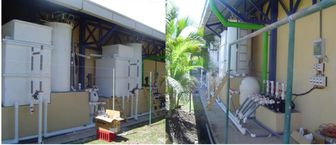
**Figura 1.4.5.** Sistemas de recirculación externos del área de maduración 1. Tomado de Chacón-Guzmán y Herrera-Ulloa (2019).
