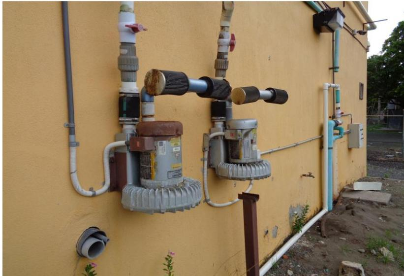
Figura 1.2.21. Sopladores centrífugos instalados verticalmente en la pared. Parque Marino, Universidad Nacional, Puntarenas, Costa Rica. (autor G. Merino)
