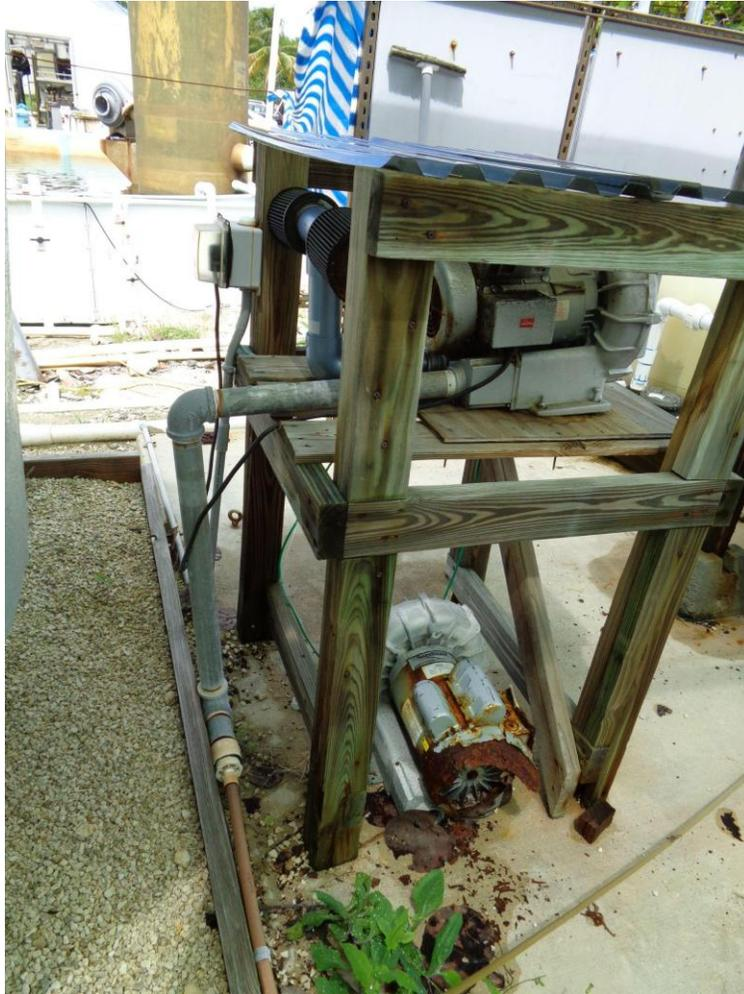
Figura 1.2.22. Sopladores centrífugos con efluente a través de tubería metálica para disipar el calor. Notar el efecto de la corrosión por la operación en ambientes marinos. Centro de Cultivo en Universidad de Miami, Florida, USA. (autor G. Merino)
