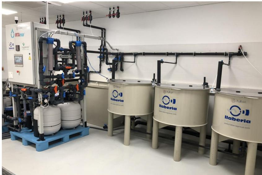
Figura. 1.3.1. Sistema de recirculación en laboratorio de investigación de peces marinos. (autor R. Carbo)
