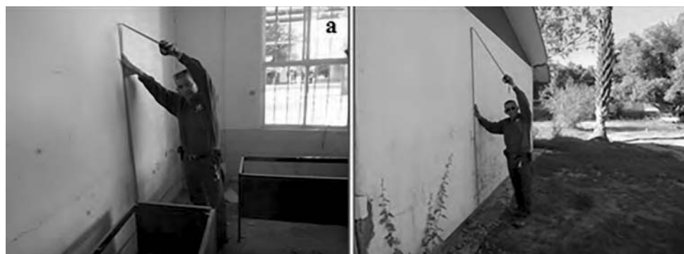
Figura 14. Mediciones del tirante de agua alcanzado en la inundación causada al paso del huracán Odile en el año 2014, a) dentro de la escuela primaria Estado de Guanajuato ubicada en la colonia La Calera, b) vivienda en la colonia El Rebaje; sus ubicaciones se muestran en la Figura 11
