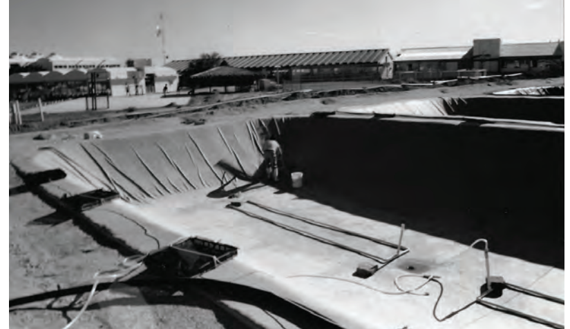
Construcción de estanques 1988
