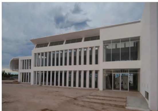
Edificio de BioHelis®
