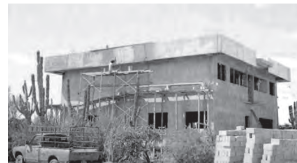
Edificio Genética en construcción
